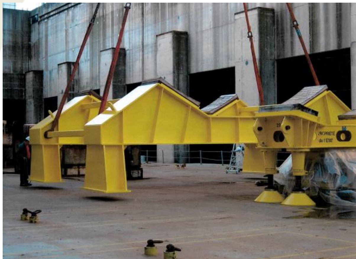
Châssis d'accueil de la tranche réacteur
